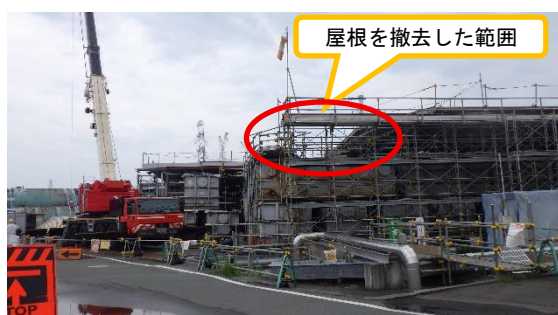
(写真 1 - 1) 屋根の撤去状況
