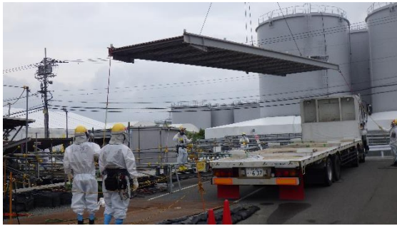
(写真 2) クレーンを使った屋根部材の積載 作業の状況
