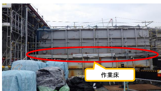
(写真 1 - 2) 作業床の設置状況
