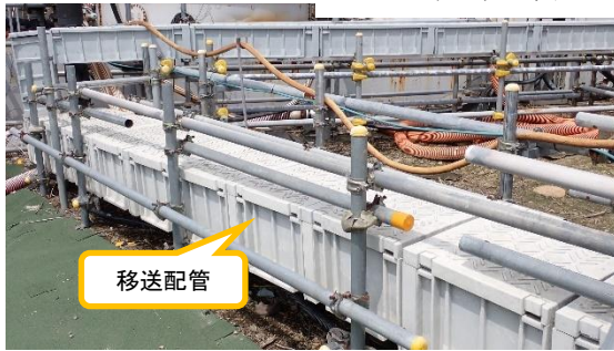
(写真1-1) 移送配管の敷設状況①
