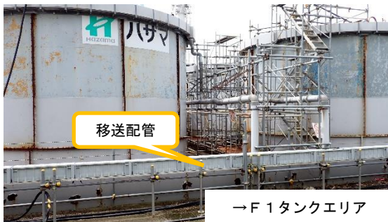
(写真1-2) 移送配管の敷設状況②
