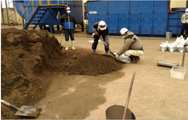
除去土壌の袋詰状況
