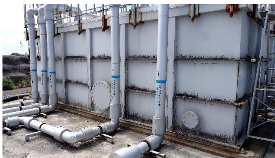
(写真 2) 一時貯留タンクの設置状況
