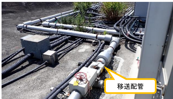
(写真 1－2) 揚水井No.6 (F) の設置状況②
