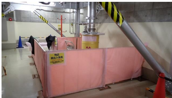
(写真 2—2) 汚染拡大防止措置の状況 (バグフィルタ直下における ばいじん捕集エリア)
