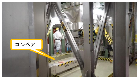
（写真2—1） 灰搬送コンベアの点検状況
