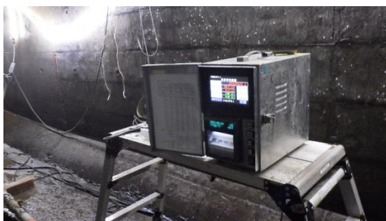
(写真 5) 陳場沢川周辺整備工事 充填作業に用いるコンクリート量 モニタ状況
