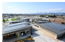
大熊町：商業施設
