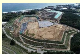
中間貯蔵施設の様子
