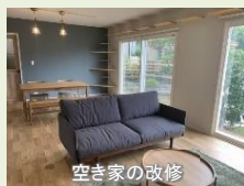
空き家の改修
