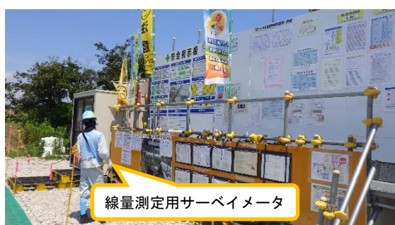
(写真3) 周辺の線量率の測定結果及び工事に係る安全掲示板の状況 (作業安全注意の他、警報レベル、熱中症対策等を掲示中) (サーベイメータを携行、各ポイントにおいて計測を実施。)
