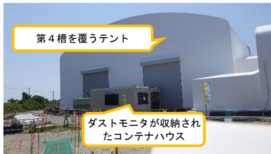
(写真1-1) コンテナハウスの設置状況 ※コンテナハウス内にダストモニタが設置されている。
