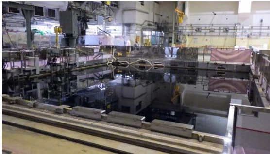
(写真3) 5号機使用済燃料プールの状況
