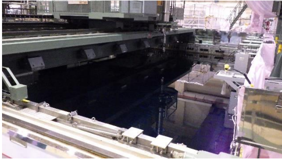
(写真2) 6号機使用済燃料プールの状況
