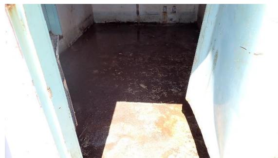
(写真1-2) SPTポンプ室の内部
