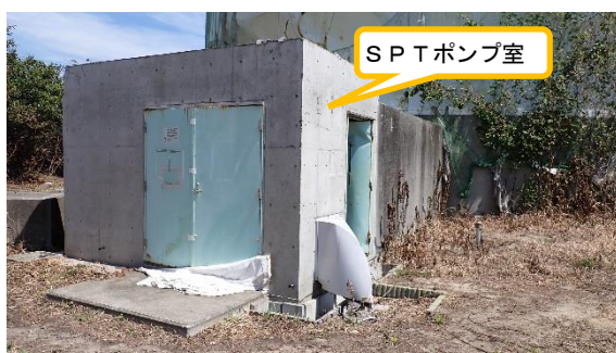
(写真1-1) SPTポンプ室の外観
