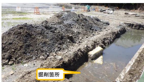
(写真2) 試掘工の状況
