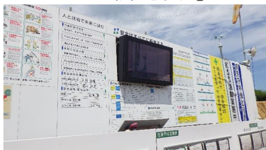
(写真 4－1) 作業安全掲示板と 熱中症予防対策
