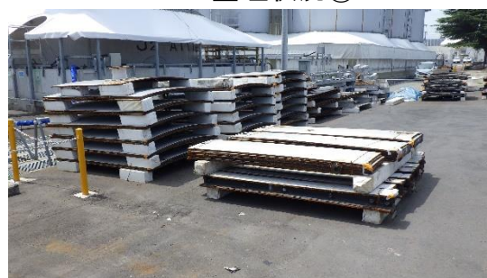
(写真 3－2) タンク切断片の 仮置き状況②
