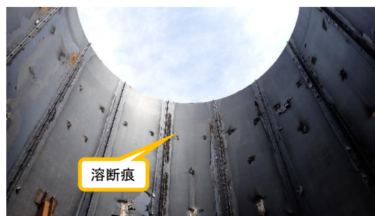
(写真 1－4) J9タンクエリア 解体状況④ (タンク内部)
