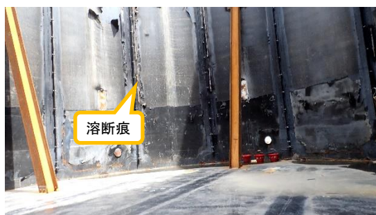
(写真 1－3) J9タンクエリア 解体状況③ (タンク内部)
