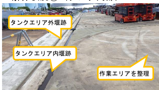
(写真 2－1) 切断作業場の 整理状況①
