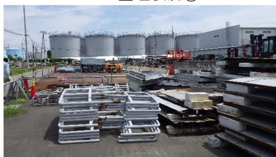
(写真 3－1) タンク切断片の 仮置き状況①
