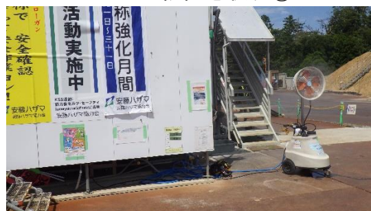
(写真 4－2) 現場事務所出入口に 設置されたミスト扇風機
