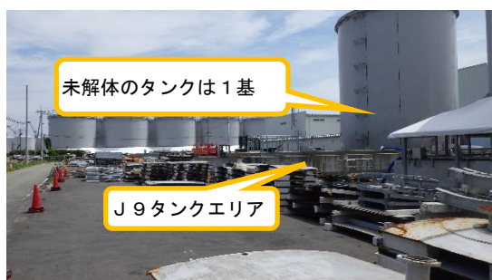
（写真1－1）J9タンクエリア 解体状況①
