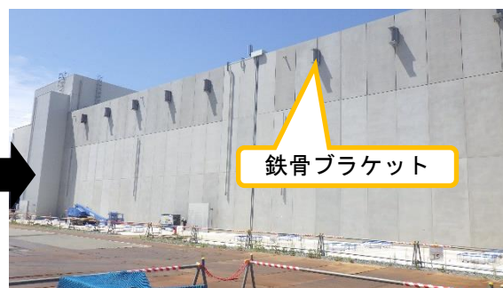
(写真 1－2) 保管庫外観東面 (令和 7 年 8 月 2 1 日撮影)
