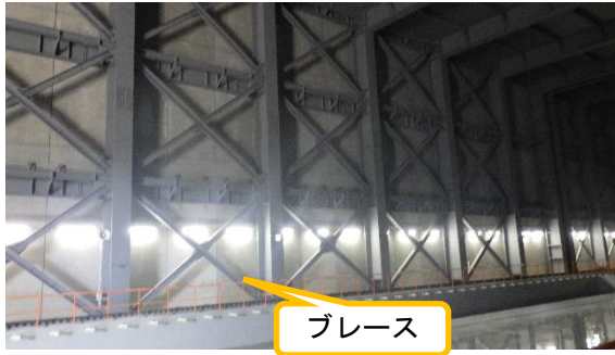
(写真3) ブレースの設置状況
