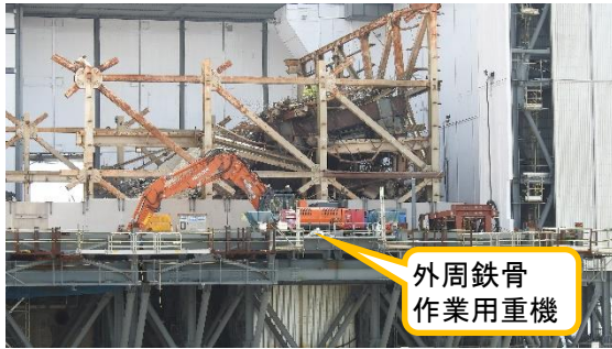
(写真 2 ①) 建屋西側 (拡大)
