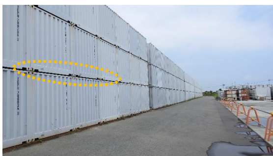
(写真 5 ①) コンテナの積上げ状態
