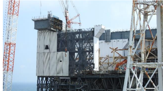
(写真 2 ②) 建屋北西側 (拡大)
