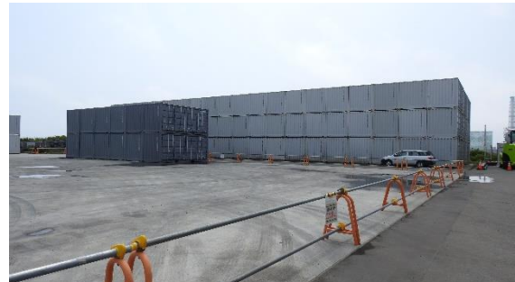
(写真 4 ②) コンテナ保管状況
