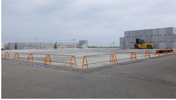
(写真6①) エリア AA 拡張部
