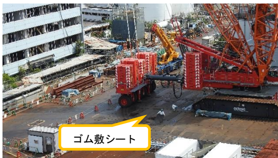
(写真 3 ①) 建屋地上部での作業①
