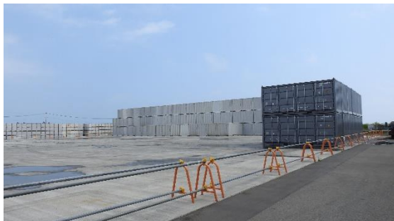
(写真 4 ①) コンテナ保管状況
