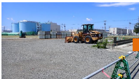
(写真5-1)一時保管エリアDDの状況(北側から令和5年6月29日撮影)
