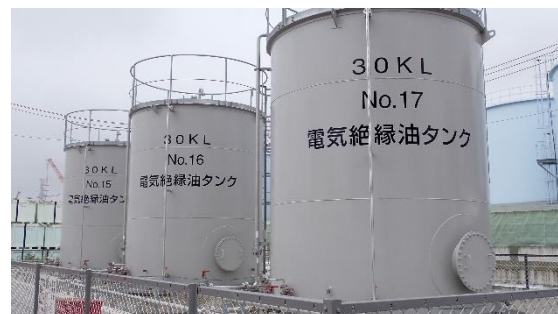
(写真7) 新設タンクの設置状況
