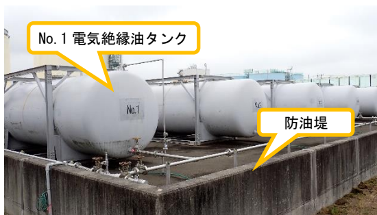
(写真6) 既設タンクの設置状況
