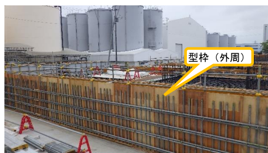
(写真1-2) 型枠の設置状況(外周)
