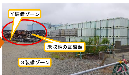
(写真5-2)一時保管エリアDDにおける瓦礫類の保管状況(北側から令和7年8月1日撮影)
