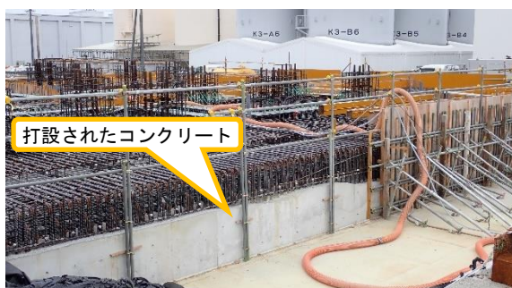
(写真1-1) コンクリート打設の状況
