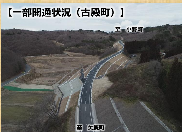
【R7施工状況】
