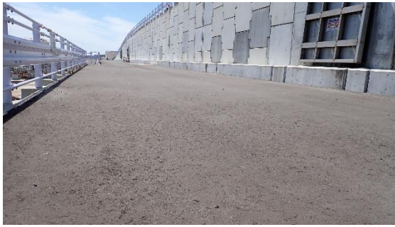
(写真 2 ③) 防潮堤海側通路の状況
