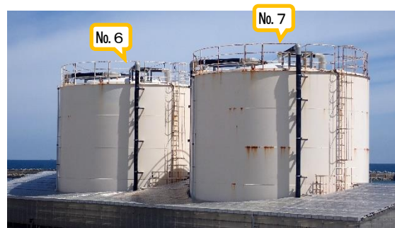
(写真 1 ②) 集水タンクNo.6及び7
