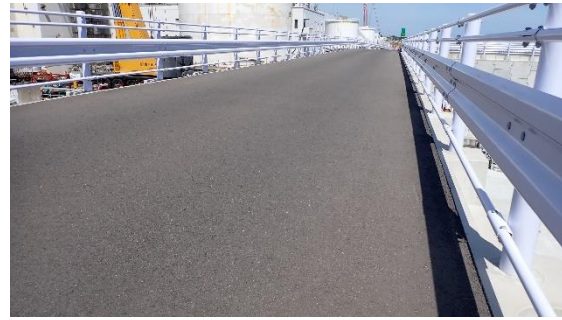
(写真 2 ④) 防潮堤上面通路の状況
