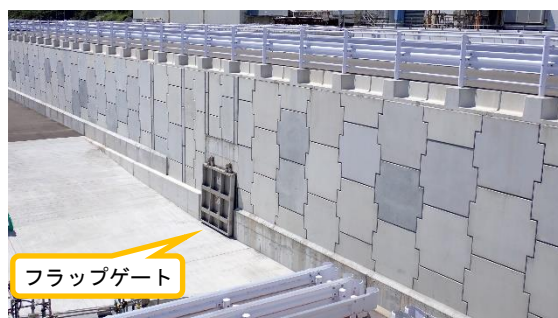
(写真 2 ①) 防潮堤の状況 (海側)
