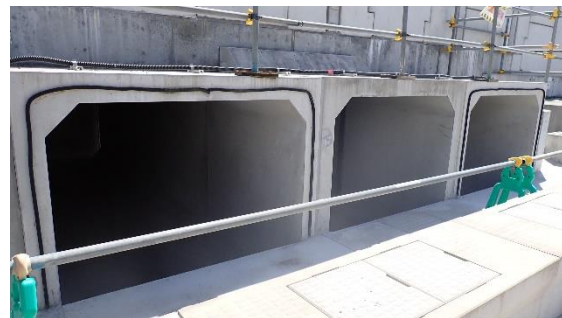
(写真 3 ②) フラップゲートの状況 (陸側)
