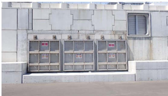
(写真 3 ①) フラップゲートの状況 (海側)
