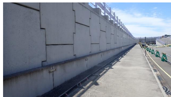
(写真 2 ②) 防潮堤の状況 (陸側)
