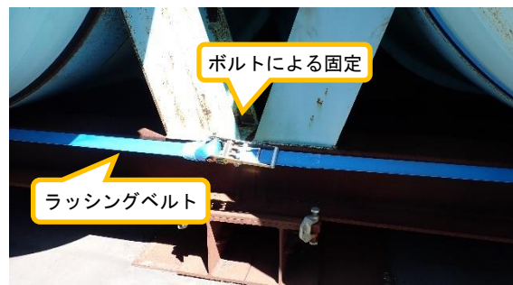
(写真 6) ブルータンクの固定状況
