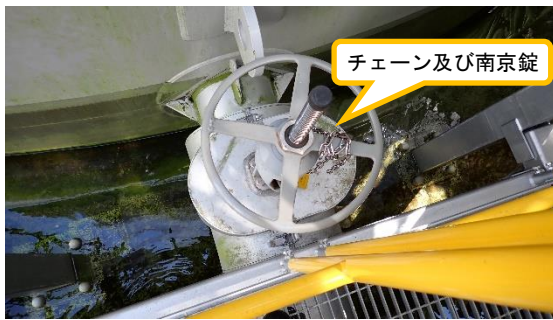
(写真 1 ①) 連結弁の状況
