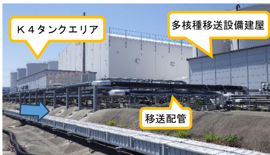
(写真 2) A L P S 処理水の移送状況
