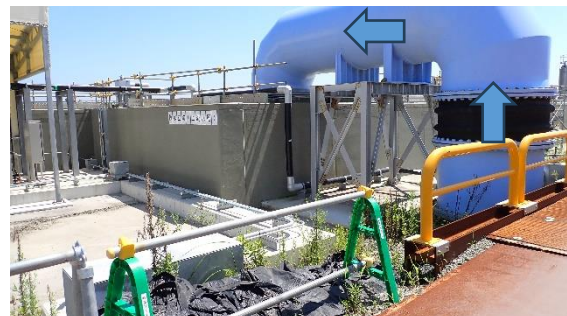
(写真 4 ②) 放水立坑の状況
