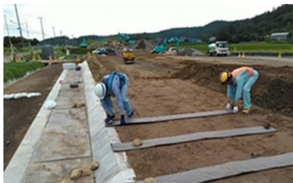
排水材設置工
