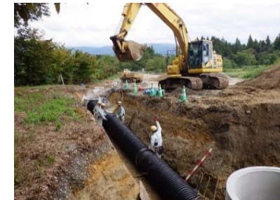
排水構造物工(暗渠排水管)
