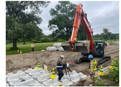
消波根固めブロック工
