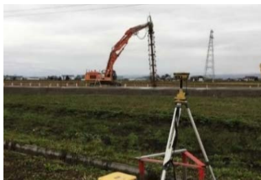
中層混合処理工(ICT)
