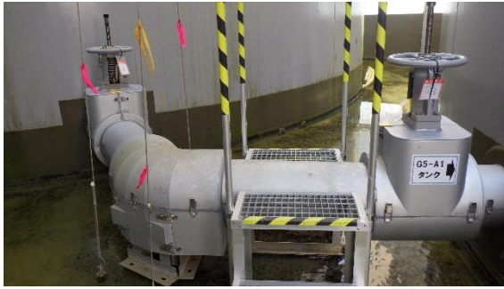
(写真3) 連結管の状況
