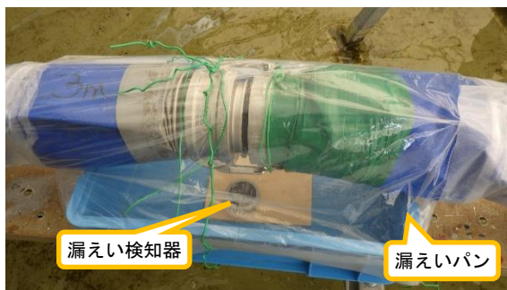
(写真2-1) 移送ホース及び漏えいパンの設置状況
