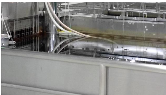
(写真4-2) 共用プールの状況②
