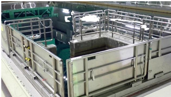
(写真4-1) 共用プールの状況①
