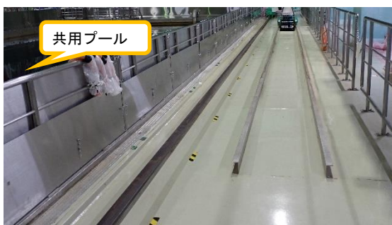
(写真2) 共用プール周囲の床面の状況
