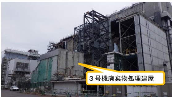
(写真5) 3号機廃棄物処理建屋の状況 ※3号機原子炉建屋北側エリア を撮影
