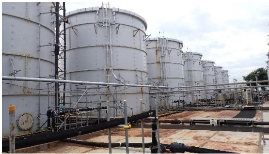
(写真 4) 旧処理設備貯留タンクの状況
