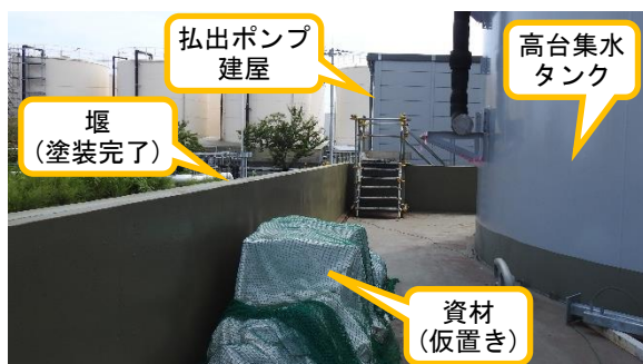
(写真 2-1) 高台における集水タンク周囲の堰の設置状況
