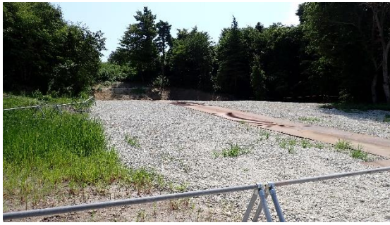
(写真 1 ③) 瓦礫類減容処理の区画 (南西側)
