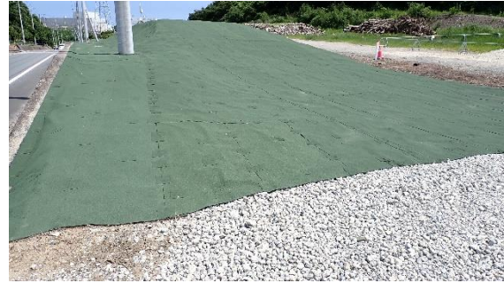
(写真 2 ①) 保護シートの敷設状況 ※西側から撮影
