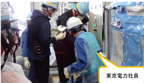
(写真 3) 東京電力社員による作業確認の状況
