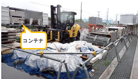
(写真 4－2) 解体片のコンテナ収納状況
