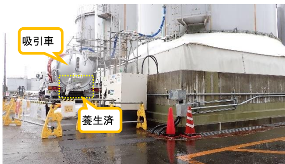
(写真 5) J 8 タンクエリアの状況
