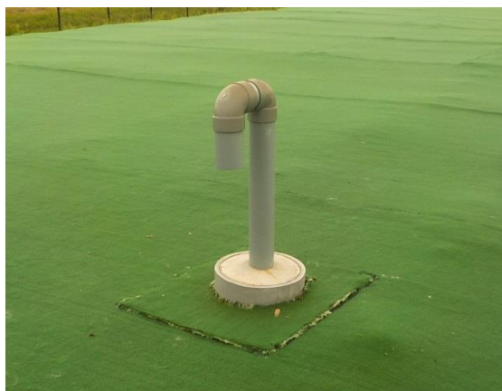
ガス抜き管基礎接合部の例
