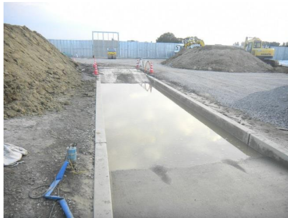
図 2-33 タイヤ洗浄設備の例
