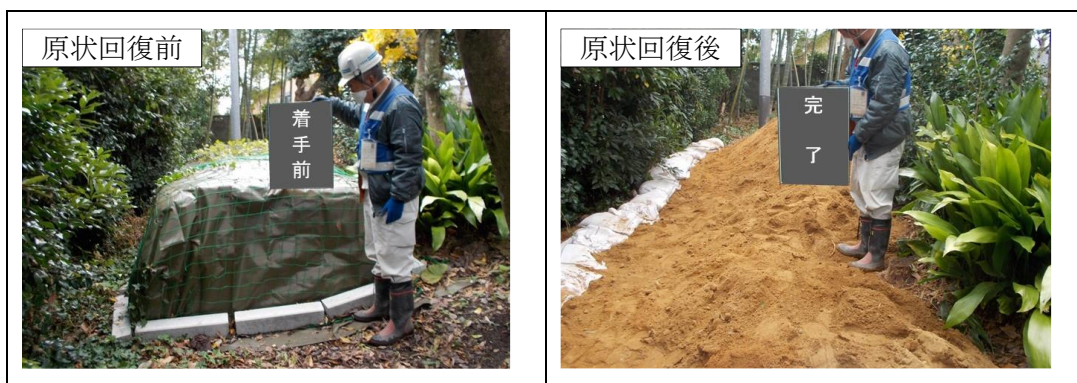
図 6-14 現場保管（宅地地上式）を原状回復した事例
