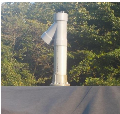
図 2-25 ガス濃度測定が容易となる例
