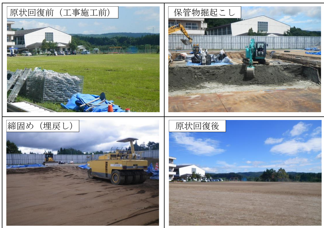
図 6-15 現場保管（学校）を原状回復した事例
