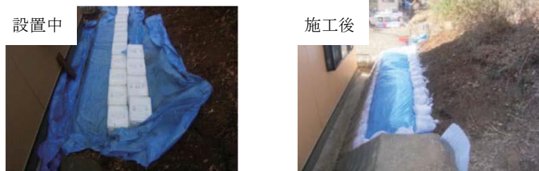
図 4-1 現場保管（地上保管）の例
