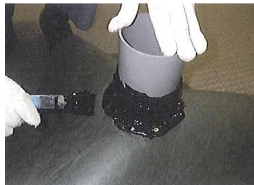
アスファルト系ホットメルト接着剤による固定例
