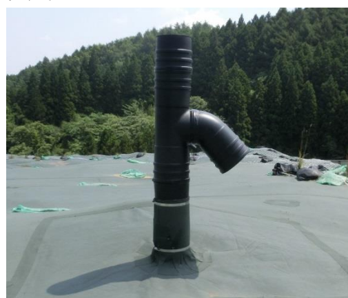
ト型ガス抜き管基礎接合部の例
