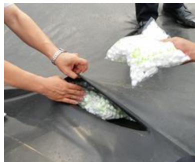
沈下した上部遮水シートと保管物の間に発泡スチロール材を挿入
