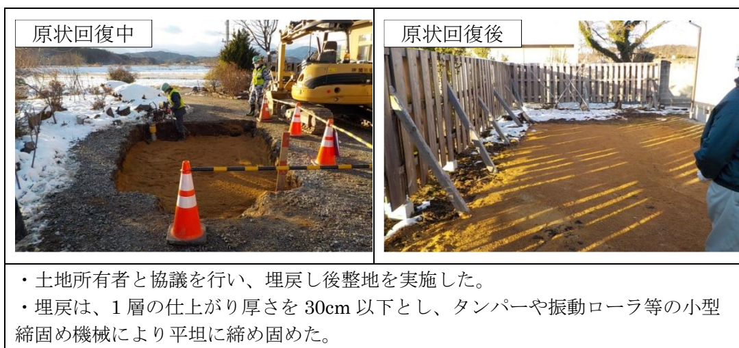
図 6-12 現場保管（宅地地下式）を原状回復した事例（1）
