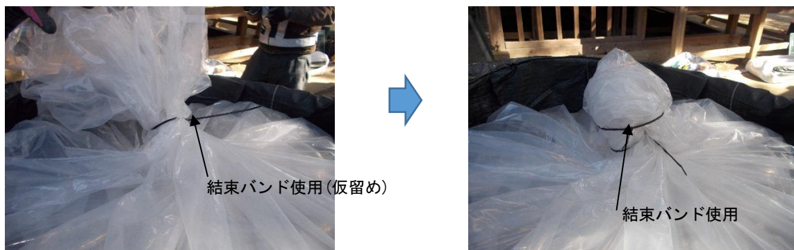
図 2-10 内袋 2 枚目の縛り方の例
