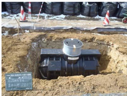
図 2-24 集水タンク（放射性物質確認用）の例
