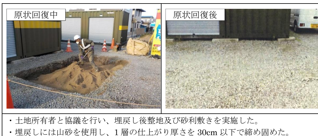
図 6-13 現場保管（宅地地下式）を原状回復した事例（2）
