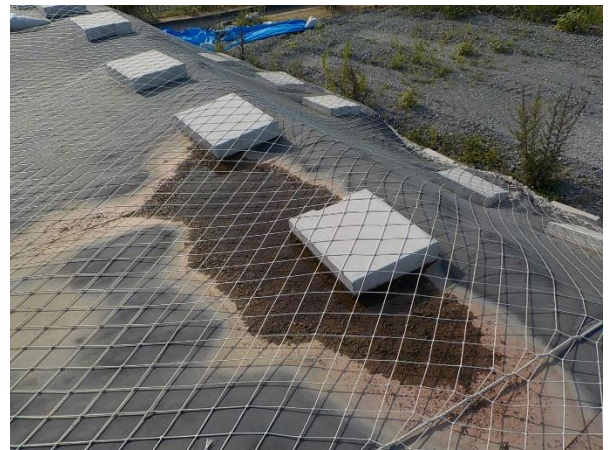
図 2-21 防風ネットによる養生例
