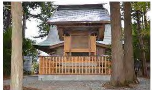
写真5 あらかじめ修理を終えた男山八幡神社本殿と玉垣 (鹿島区寺内 H30. 4. 7)
