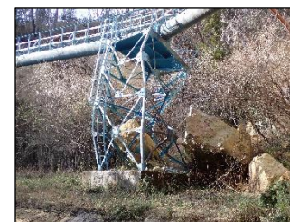
【復旧前】 （管路・橋脚が破損）
