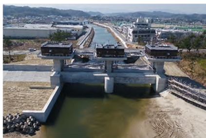
④ 水門 (いわき市)
