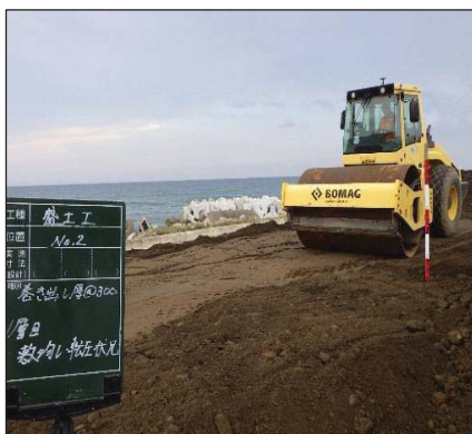
締固め管理システムによる 築堤盛土
