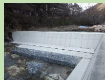
老朽化した頭首工の補修
