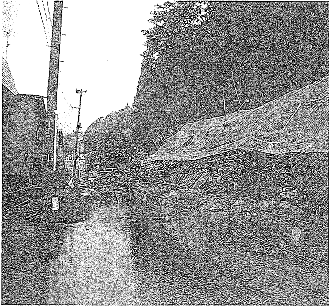
土砂崩れが起きる国道289号＝29日午後6時50分ごろ、只見町小林
