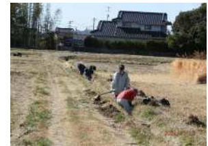
多面的機能支払事業 水路の泥上げ作業の様子
