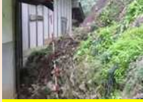
山腹崩壊地(福島市)
