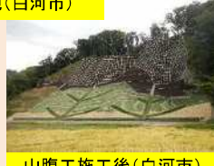
山腹工施工後(白河市)
