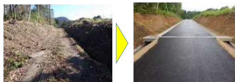
農道整備（南会津町）
