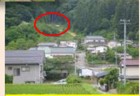
治山ダム施工地(伊達市)
