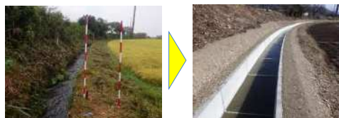
農業用排水施設整備（南会津町）
