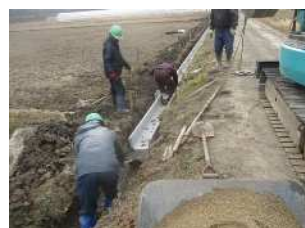
多面的機能支払事業 コンクリート水路設置の様子
