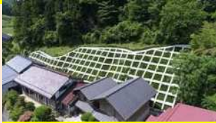
山腹工施工後(福島市)
