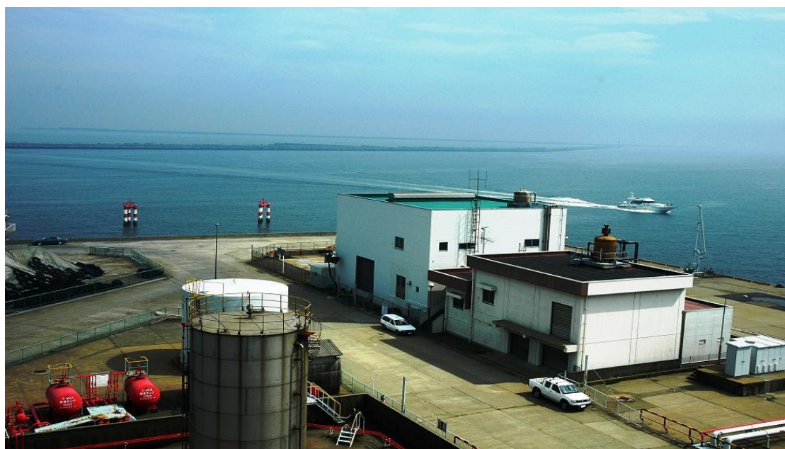
【小名浜ポンプ場】
