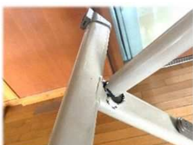
生徒用椅子破損個所の修繕
