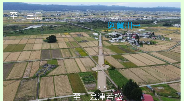
工事の進捗状況
