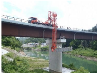
①橋梁点検を定期的を実施
