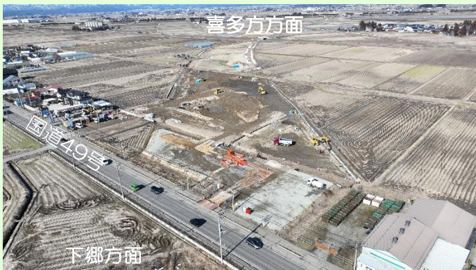
【写真】盛土工事の様子
