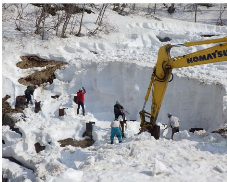
人力で除雪しています
