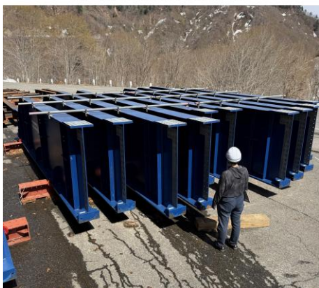
部材の除雪完了！
