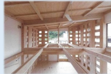
大径材を活用した木造建築物
