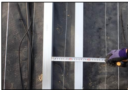
①防草シート設置後、②培地(ロックウールマット)が乗る幅に角材を配置していきます。
