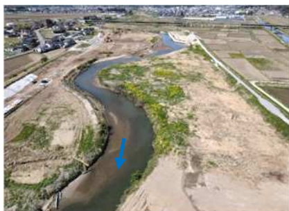
▲ 令和元年度台風被災後 (令和2年8月)
