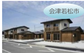
復興公営住宅：戸建
