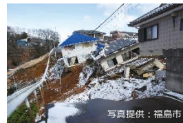
家屋被害：福島市
