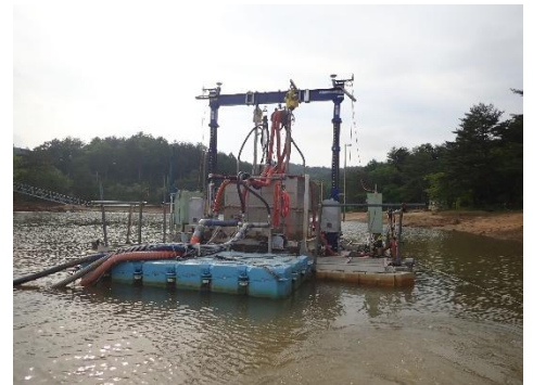
ため池の底質をポンプ浚渫する状況
