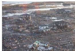
津波被害：浪江町
