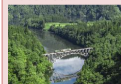
只見線 第一只見川橋梁
