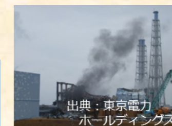
水素爆発を起こした直後の3号機
