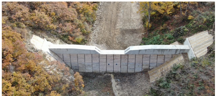
治山事業による荒廃溪流の復旧(只見町宮ノ上山)
