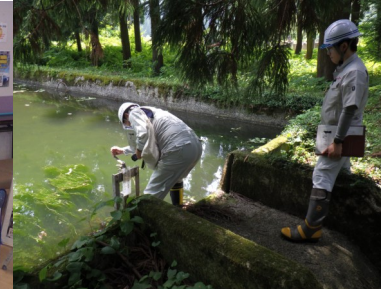
農業水利施設の合同診断
