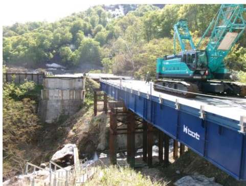
只見側から施工しています
