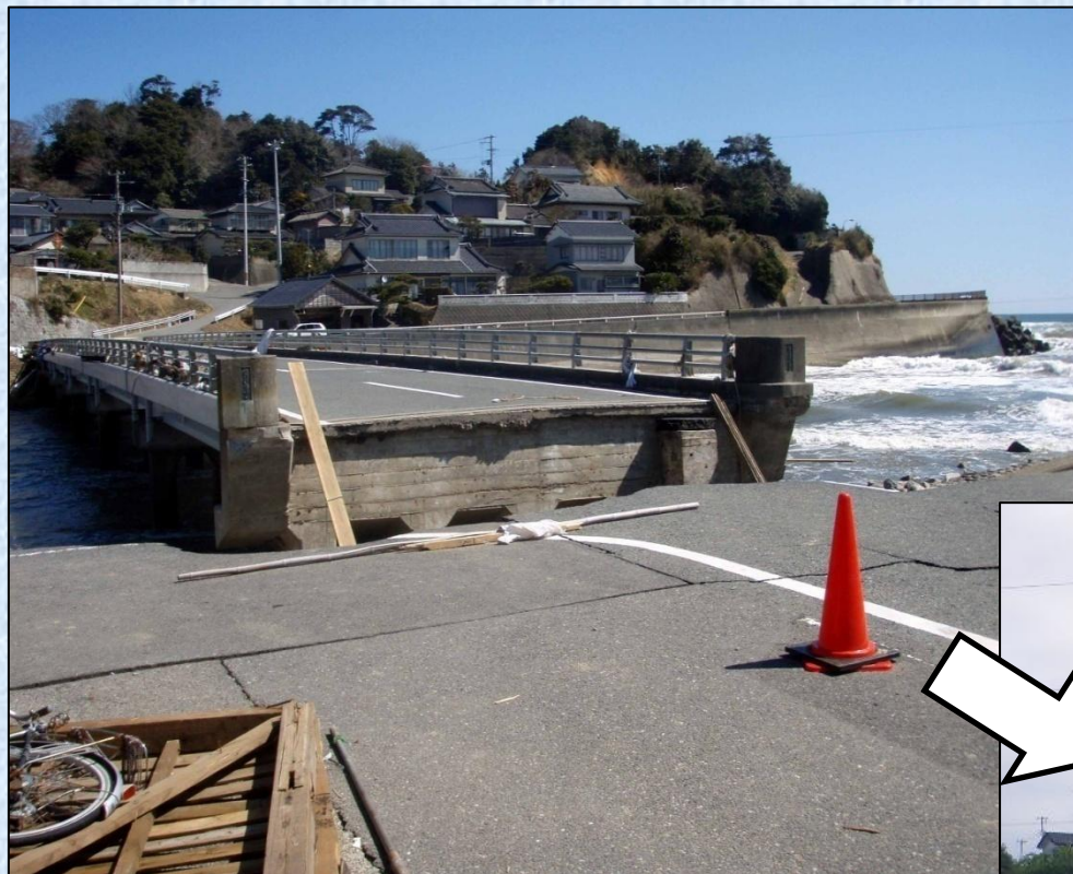
桥梁接续处崩落〔县道久之浜港线〕
