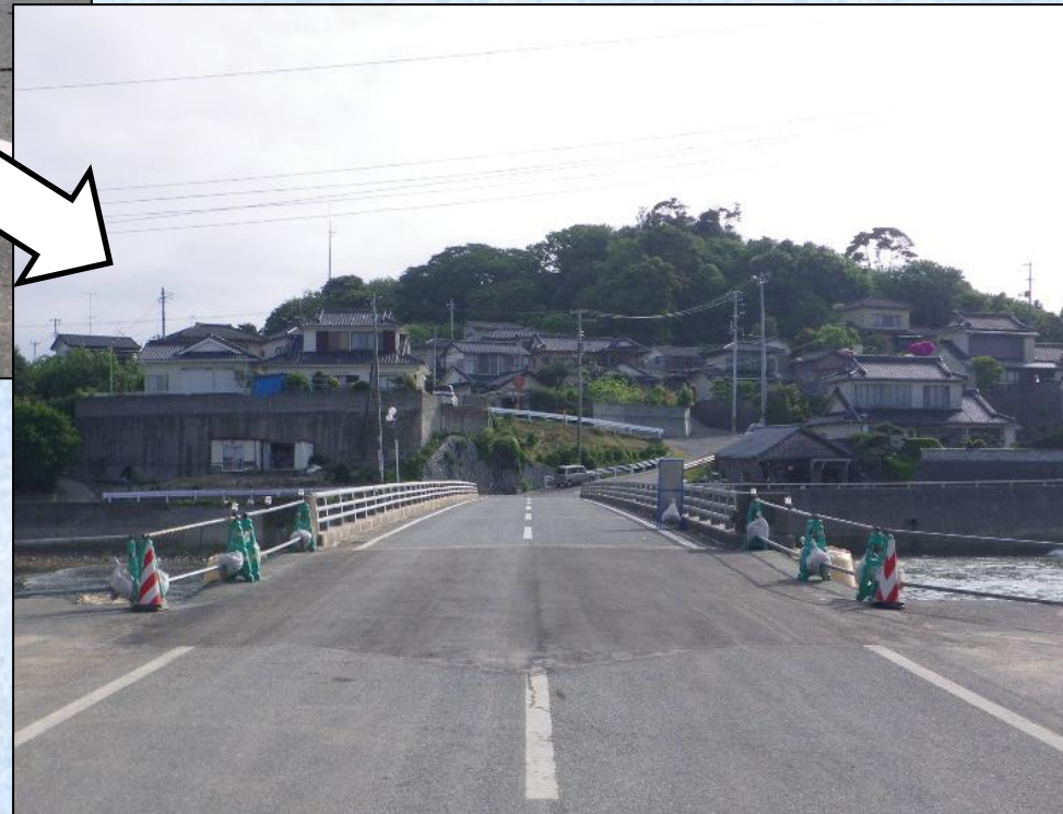
桥梁接续处崩落〔县道久之浜港线〕
