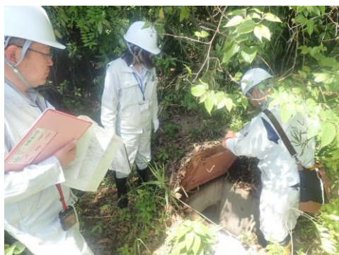
▲承水路工の確認(上荒川)
