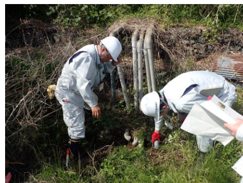
▲水抜きボーリング工の確認(上平石)
