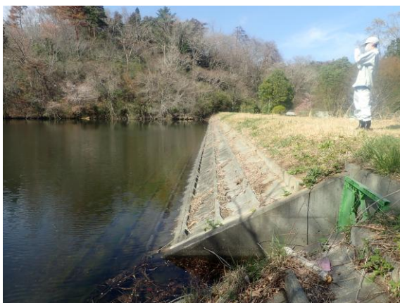
▲波除工の確認（鞍掛池）
