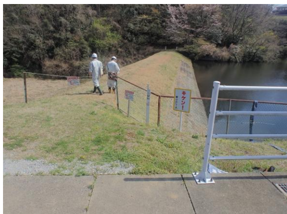
▲堤体植生・はらみだし等の確認（下堤池）
