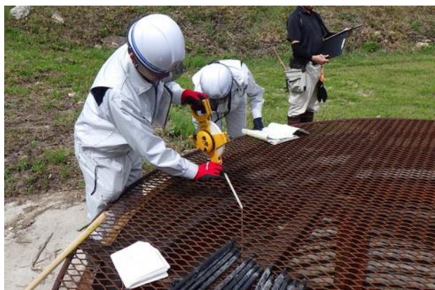
▲集水井工の点検状況
