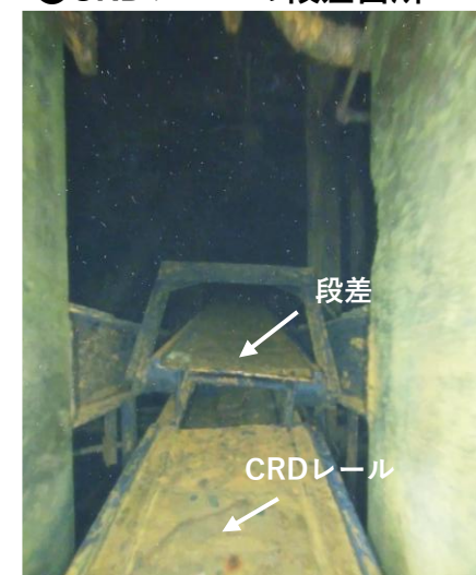
④CRDレールの段差箇所
