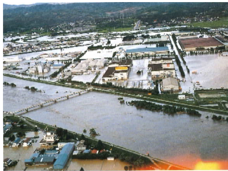
昭和61年8月洪水 郡山市中央工業団地の浸水状況
